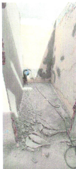
Foto 20 - Demolição manual de piso cimentado sobre lastro de concreto - Rev 01
