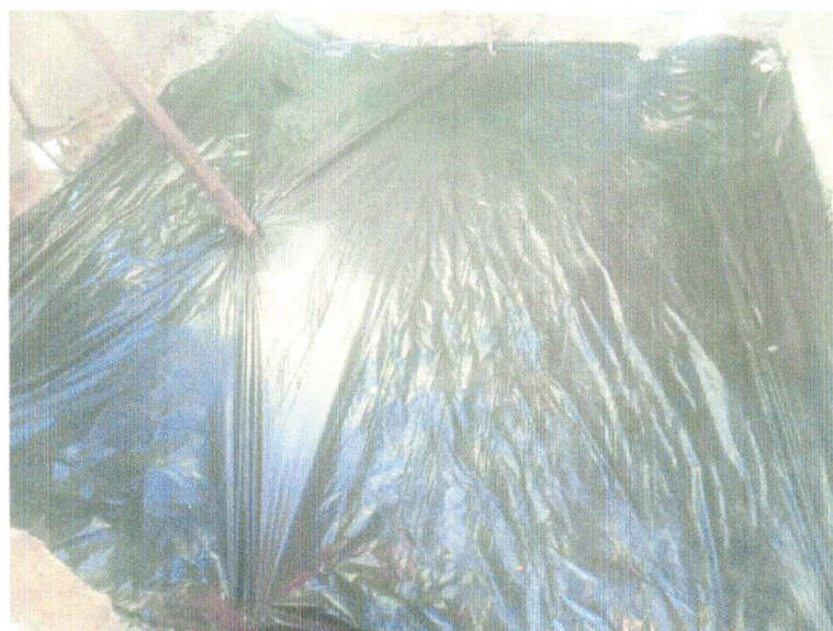
Foto 23 - APLICAÇÃO DE LONA PLÁSTICA PARA EXECUÇÃO DE PAVIMENTOS DE CONCRETO. AF_04/2022
