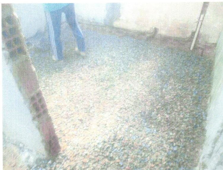
FOTO 04 - Lastro de brita graduada apiloada e=10cm
