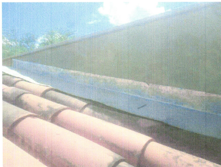
Foto 27 - Rufo em chapa aço galvanizado nº24 com desenvolvimento 25cm
