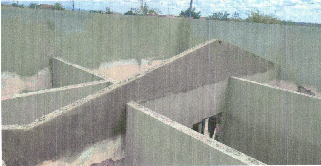
Foto 25 - MASSA ÚNICA, PARA RECEBIMENTO DE PINTURA OU CERÂMICA, ARGAMASSA INDUSTRIALIZADA, PREPARO MECÂNICO, APLICADO COM EQUIPAMENTO DE MISTURA E PROJEÇÃO DE 1,5 M 3 /H EM FACES INTERNAS DE PAREDES, ESPESSURA DE 5MM, SEM EXECUÇÃO DE TALISCAS. AF_06/2014
