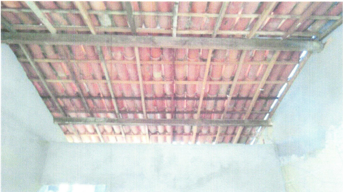
FOTO 30 - Retelamento em cobertura com telha ceramica tipo canal comum, Itabaiana ou similar.
