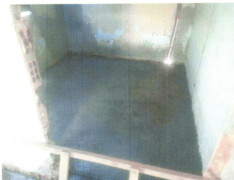
FOTO 13- PISO EM CONCRETO 20 MPA PREPARO MECÂNICO, ESPESSURA 7CM. AF_09/2020
