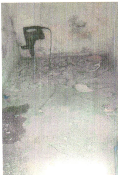
Foto 18 - Demolição manual de piso cimentado sobre lastro de concreto - Rev 01
