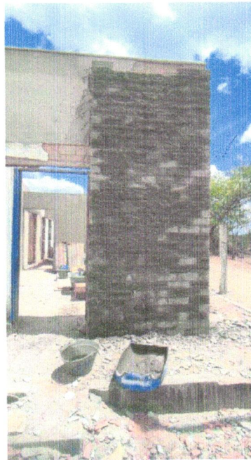
Foto 07– CHAPISCO APLICADO EM ALVENARIA (COM PRESENÇA DE VÃOS) E ESTRUTURAS DE CONCRETO DE FACHADA, COM EQUIPAMENTO DE PROJEÇÃO. ARGAMASSA TRAÇO 1:3 COM PREPARO EM BETONEIRA 400 L. AF 06/2014
