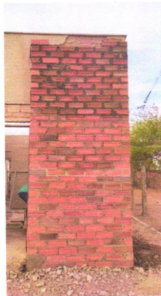
FOTO 01 - Alvenaria tijolo cerâmico maciço (5x9x19), esp = 0,05m (facão), com argamassa traço t5 - 1:2:8 (cimento / cal / areia) c/ junta de 2,0cm - R1
