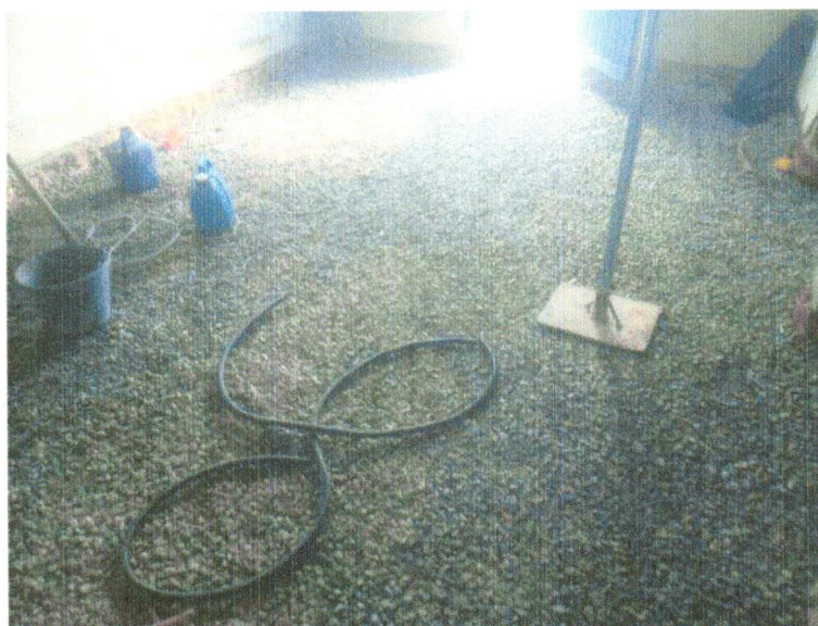
FOTO 05 – Lastro de brita graduada apilada e=10cm
